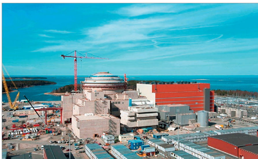
Figure 10.1: EPR construction at Olkiluoto site in May 2011 [Source: Teollisuuden Voima Oyj] [Source: Teollisuuden Voima Oyj (TVO)].
